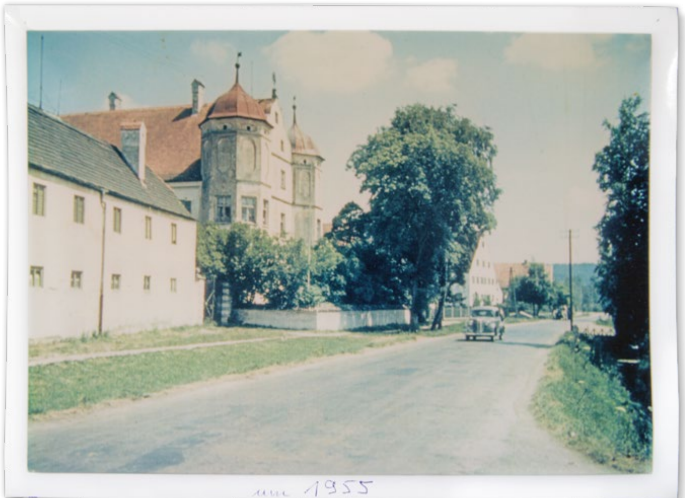
Schloss Rudolfshausen um 1955. Damals standen die desolaten Nebengebäude noch. Das Schloss selbst war ebenfalls in einem schlechten Zustand.
